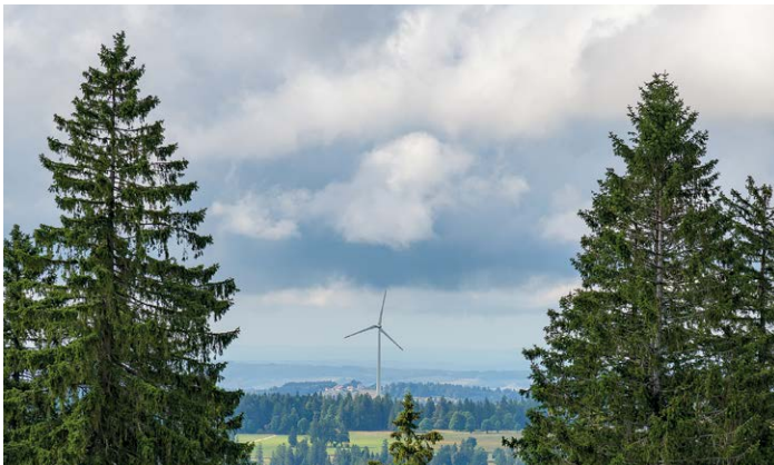
Wenn der Wind kräftig über den Mont Crosin und Mont Soleil fegt, werden die 16 Windturbinen stark gefordert. Foto: Thomas Richard
